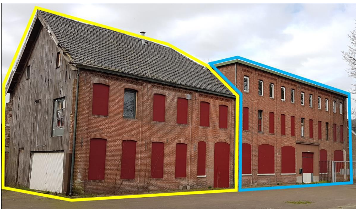
Figuur 2. Gebouw 2 met daarbinnen gebouw 2a (geel omkaderd) en gebouw 2b (blauw omkaderd).
