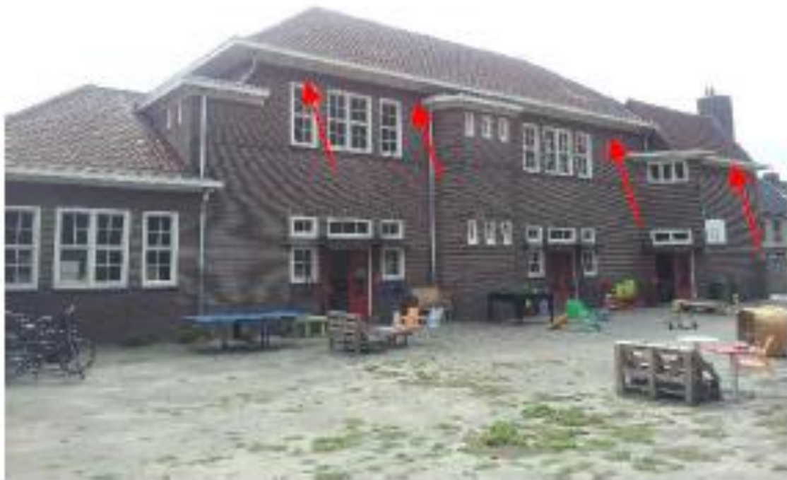
Figuur 4. Locaties van de permanente voorzieningen, acht openingen in de houtenbekisting, in de gevel rondom het gebouw aan de Barrierweg 180.
