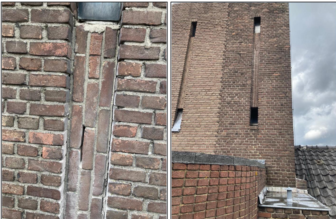
Figuur 6. Impressie van de nieuwe kraam- en zomerverblijfplaats van de laatvlieger in oostelijke risaliet.
