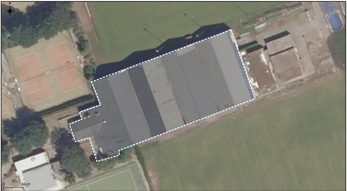
Figuur 1. Locatie van de te slopen sporthallen gelegen aan de Sportlaan 1, 5831 DA te Boxmeer. De activiteiten vinden plaats binnen de wit gestippelde omlijnde bebouwing.
